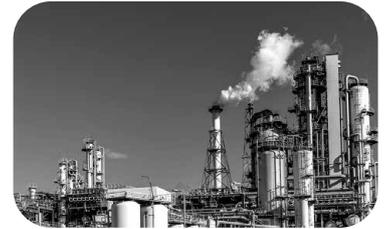
地下からほりだした（ **原油** ）は、（ **タンカー** ）で日本に運ばれ、（ **石油せいせい** ）工場に送られる。工場では、原油を熱して、ガソリン、ナフサ、灯油、軽油、重油、アスファルトに分ける。
